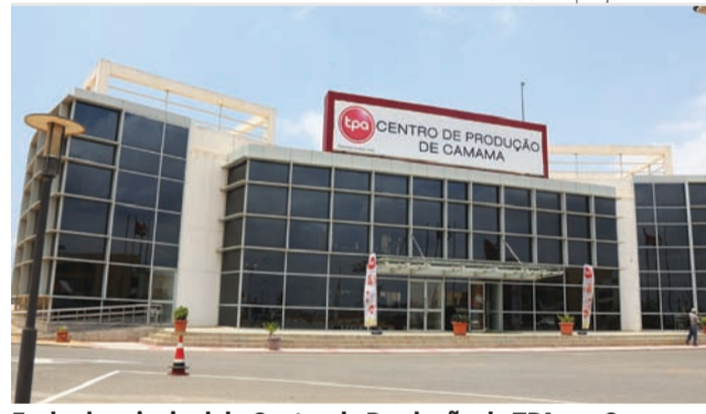
Fachada principal do Centro de Produção da TPA, no Camama
